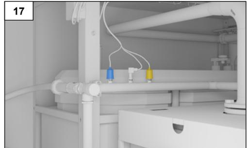
Die oberen oder unteren Druckschalter schalten, wenn der Primärdruck außerhalb des Bereichs von 0,5 bis 4,5 Bar liegt.
